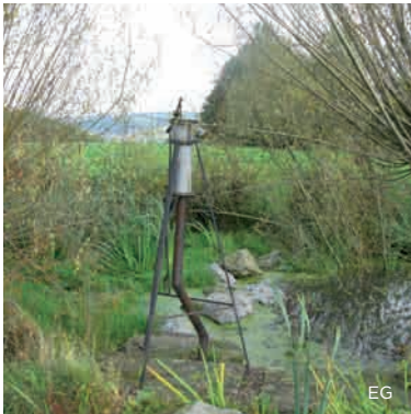
L'ancienne pompe communale de la mare d'Hansez
