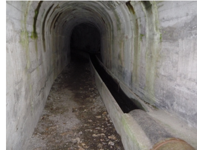
Der 1972 erbaute Stollen
