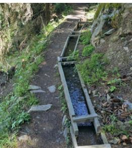
Als «Bänne» bezeichnet man einen aus Brettern gezimmerten Wasserkanal. Um das Versickern des Wassers zu vermeiden, befindet sich in diesem Hang mit stark durchlässigem Boden eine «Bänne». Erst nach der Sanierung der Trusera im Jahre 2007 stellte man hier einen starken Wasserverlust fest,
