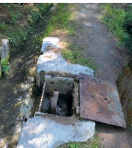
Früher konnte hier mit diesem Abschlag auch ein darunterliegendes Wasserreservoir gefüllt werden, um bei einem Brand genügend Löschwasser zur Verfügung zu haben. Der Zeitpunkt des «Abschlagens» des Wassers erfolgte nach der festgelegten «Kehrorndnung».
