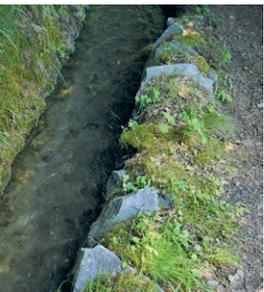
kleiner Geschwindigkeit kann sich kleines Geschiebe wie Blätter und Lärchennadeln verfangen und das Wasser stauen, und zu grosse Geschwindigkeit verstärkt die Erosion. Daher weisen die Wasserfuhren meistens ein eher schwaches Gefälle auf. Und es erstaunt, wie sie ohne technische Nivellierungsinstrumente sicher angelegt worden sind.
