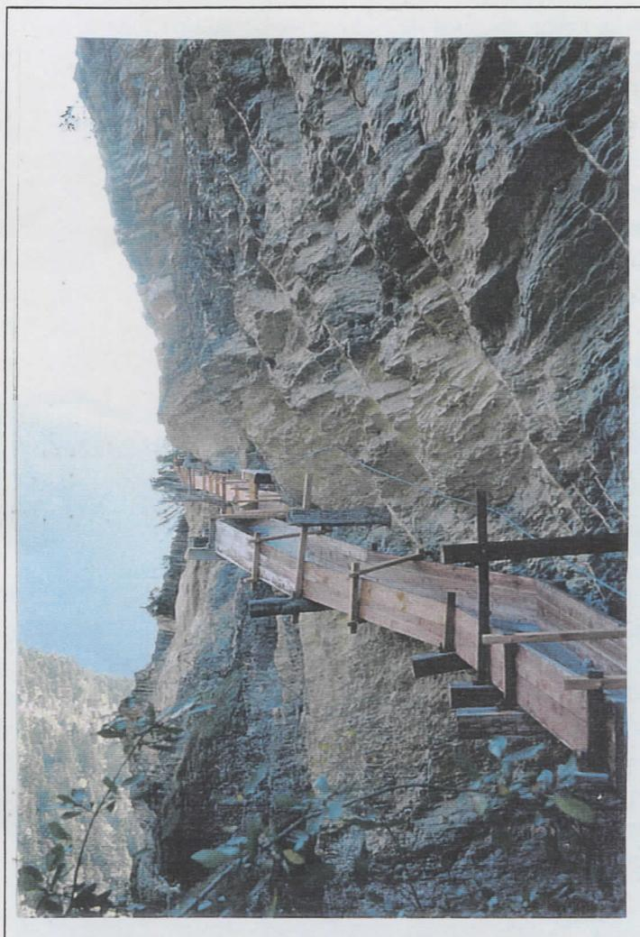
*Photo 12 - Reconstitution d'une section du bisse d'Ayent sur les anciennes poutres dans la paroi rocheuse de Torrent-Croix*
