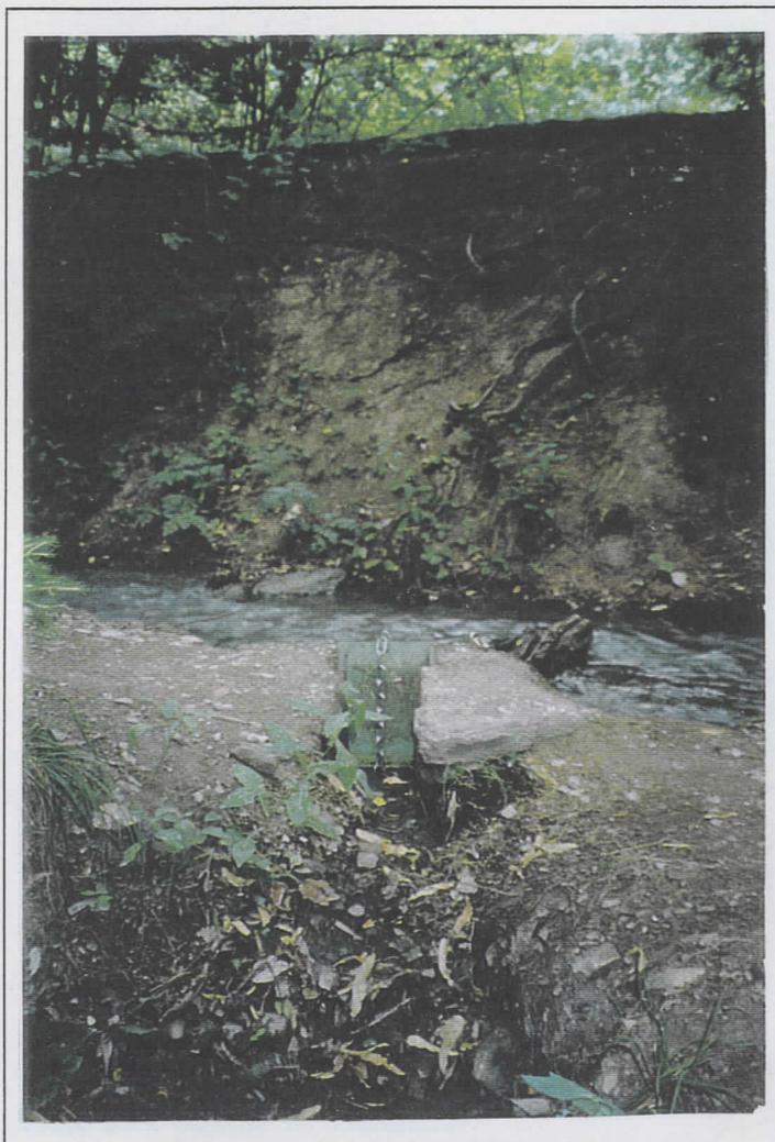
*Photo 2 - Ecluse de répartition sur le bisse de Savièse avec le canal principal du bisse à l'arrière-plan et une rigole de répartition au premier plan*
