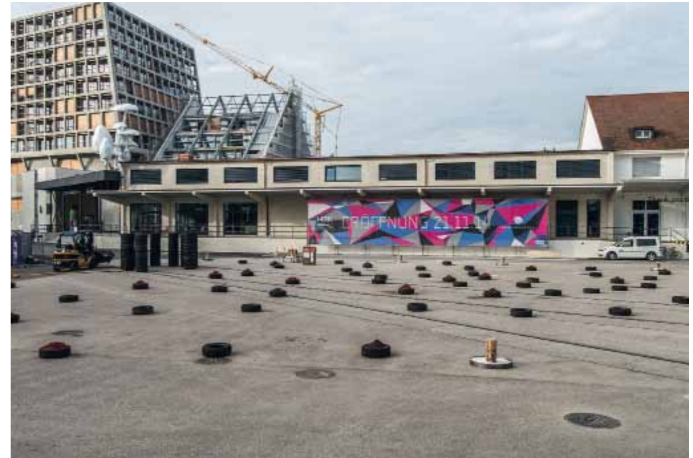
Ein altes Gebäude in neuem Glanz: Das HeK kurz vor seiner Wiedereröffnung am Dreispitzareal. © Christoph Merian Stiftung/Kambiz Shafei
