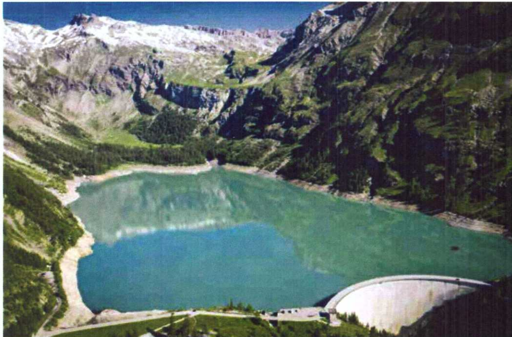
Le barrage hydroélectrique de Tseuzier, mis en service en 1957. (PHOTOS: SEDRIK NEMETH POUR LE TEMPS)
