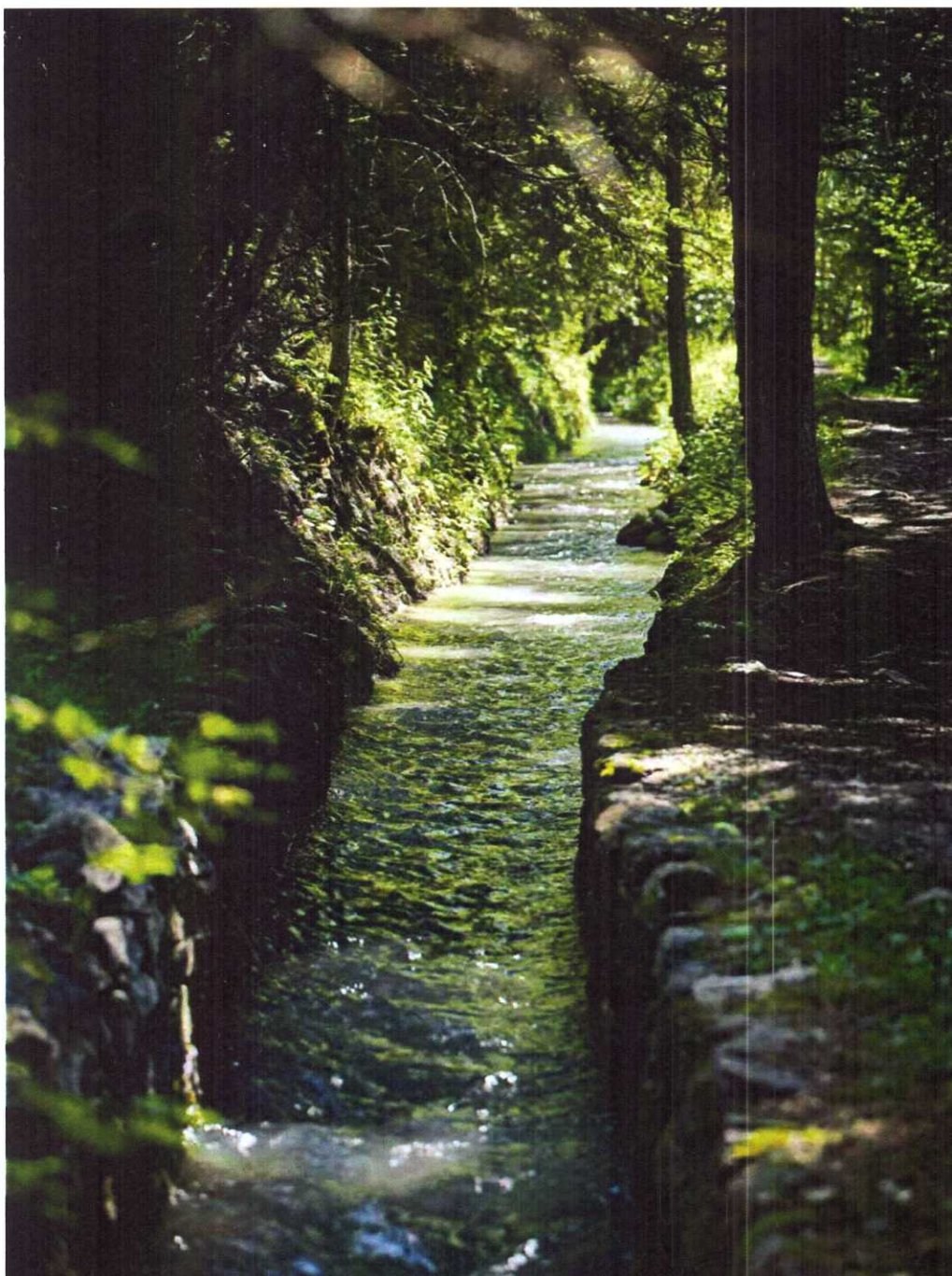
Le bisse d'Ayent prend sa source dans le barrage de Tseuzier et se déverse dans l'étang de Revouire.
