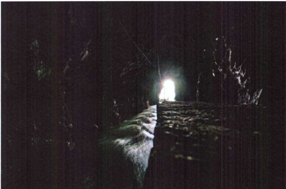
La galerie de 95 mètres a été creusée en 1831, pour éviter le passage escarpé de Torrent-Croix.
