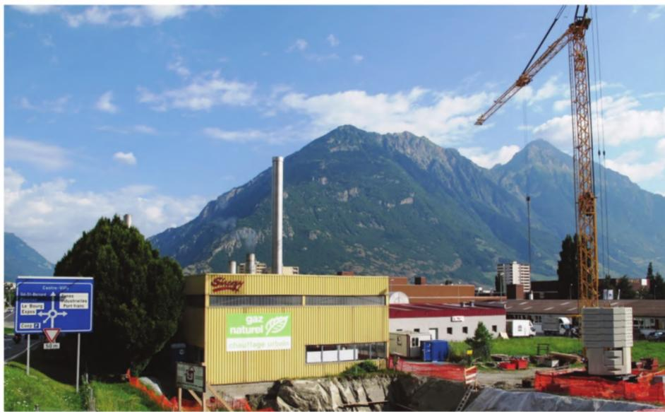
Les travaux ont débuté en juin, ici, à l'extérieur, pour aménager le silo qui contiendra les copeaux, et à l'intérieur pour préparer l'installation de la chaudière. Mise en service prévue pour novembre. LE NOUVELLISTE
