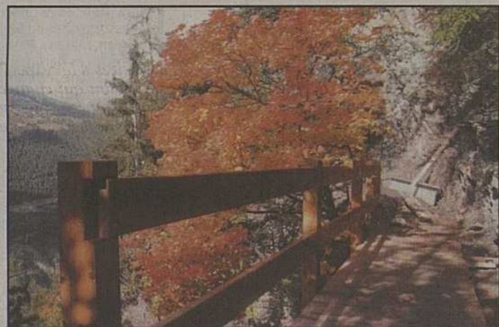
Plus d'un kilomètre de sentier pédestre a déjà fait l'objet d'un méticuleux réaménagement, comme ici au lieu-dit Saut du poulin. LDD
