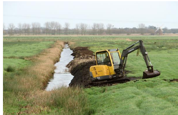
Figure 6 : Travaux d'entretien sur un fossé de drainage en Grande-Bretagne. (Source : Evelyn Simak/geograph.org.uk)
