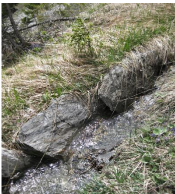
Figure 20 : Renforcement du lit du « canal de Côte Plane » avec des lauzes, Lanslevillard. Cliché Villette, 2012.
