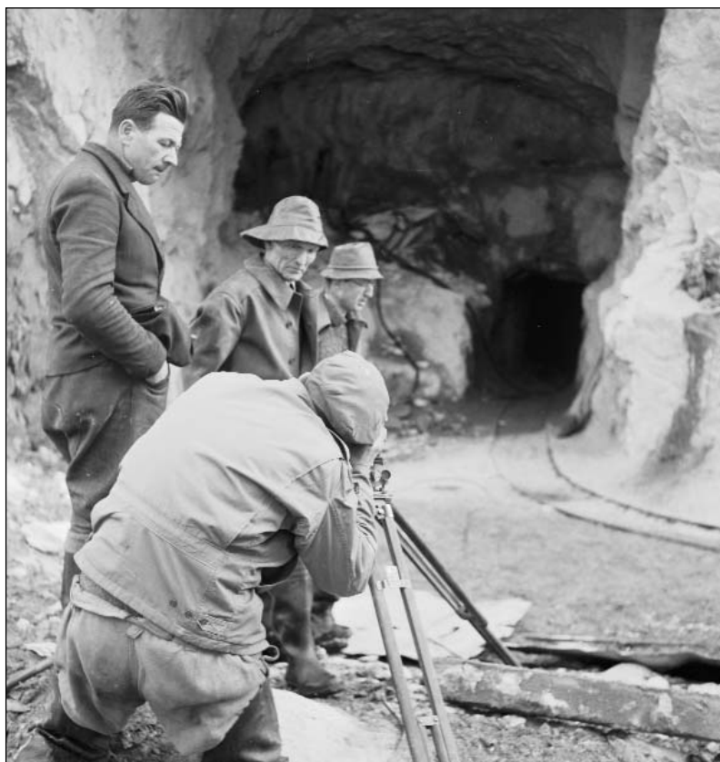
Tunnel du Riederhorn. Les géomètres et ingénieurs au travail devant l'entrée du tunnel. Riederhorn-Tunnel. Geometer und Ingenieure bei der Arbeit vor dem Tunneleingang.
