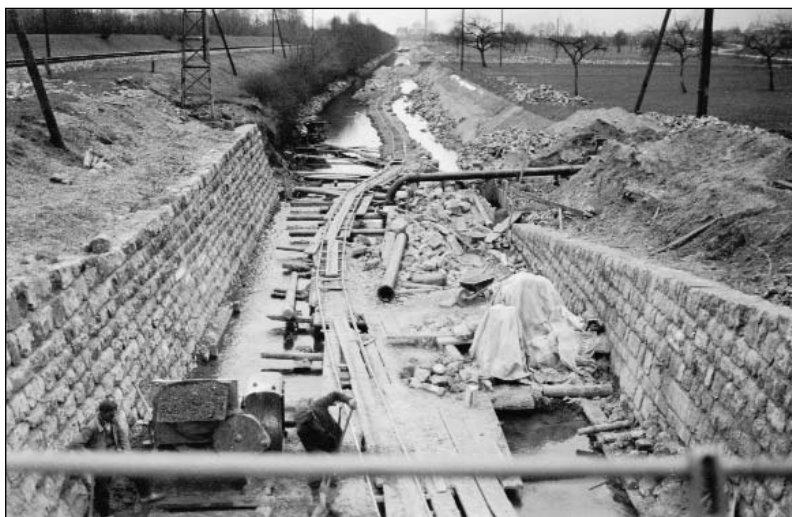
Les travaux sur le canal Stockalper tels qu'ils se présentent le 8 février 1935. Arbeiten am Stockalperkanal, 8. Februar 1935.
