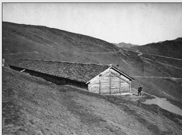
Alpage des Grands-Plans, Verbier. Etable construite en 1910 pour 160 vaches. Alpe Grands-Plans, Verbier. Stall für 160 Kübe, erbaut im Jahre 1910.
