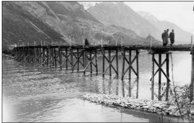
Passerelle sur le Rhône à Saxon, construite dans le cadre du remaniement parcellaire de 1932.
