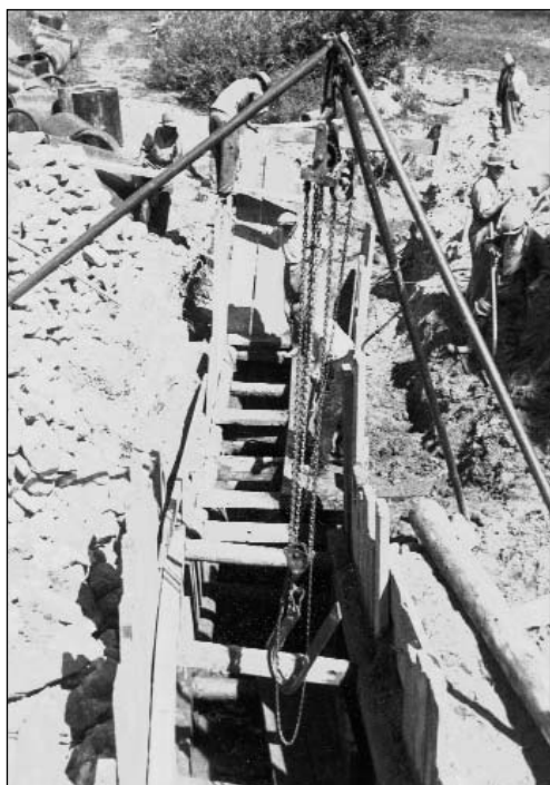
Construction de la canalisation pour l'irrigation du vignoble de Chamoson.
