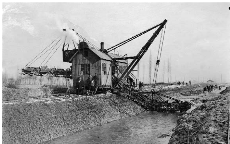
Canal Riddes-Martigny, travaux d'assainissement. Kanal Riddes-Martinach, Entsumpfungsarbeiten.
