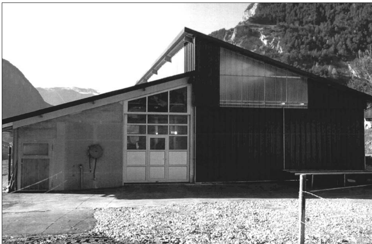
Etable de M.David Moulin, Etiez/Vollèges, terminée en octobre 2003. Stall von David Moulin, Etiez/Vollèges, fertig gestellt im Oktober 2003.
