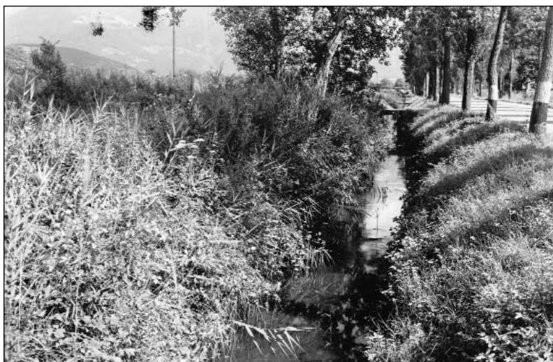
Canal Stockalper. Situation avant le début des travaux de correction en 1931, près de Collombey. Stockalperkanal. Vor Beginn der Korrektionsarbeiten, 1931, bei Collombey.
