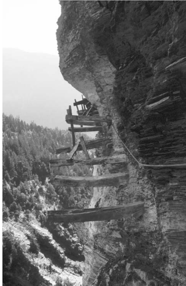
Photo 2 Vestiges (boutsets) du bisse d'Ayent à Torrent-Croix. Sur ce secteur, le canal, autrefois suspendu contre la paroi, a été remplacé par un tunnel creusé en 1831. Ces vestiges ont été restaurés en 1991 et 1997 (voir photo 3).
