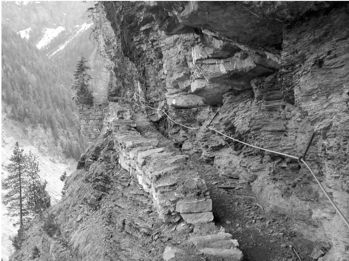
Photo 3 Passage des Follets, abandonné au moment de la mise en service des installations hydroélectriques de Lienne SA. Actuellement, le bisse est mis en eau à l'aval de ce passage dangereux, au lieu-dit Samarin.
