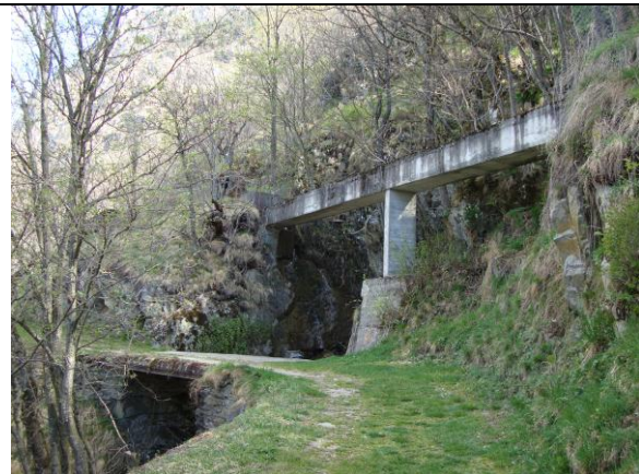
Alter Betonschacht am Steigrächa
