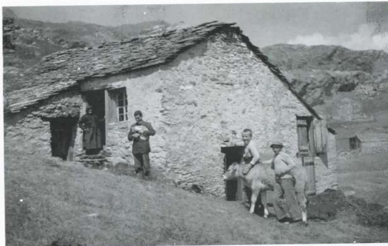
Typische Alphütte aus Mörtelmauerwerk, gedeckt mit Gneisplatten, im Simplongebiet: unten die Stallung, oben Wohnraum, rechts kleine Scheune, links angebaut der Keller.
