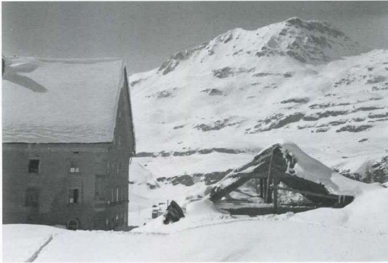
1971 hat die Lawine vom Hübschhorn das umgebaute Stallgebäude so stark beschädigt, dass es abgerissen werden musste.
