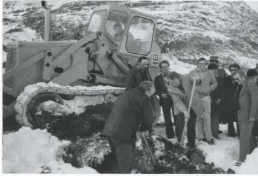
Der erste Spatenstich für den Bau der unterirdischen Truppenunterkunft auf dem Boden der Simplon Bergalpe (sb)
