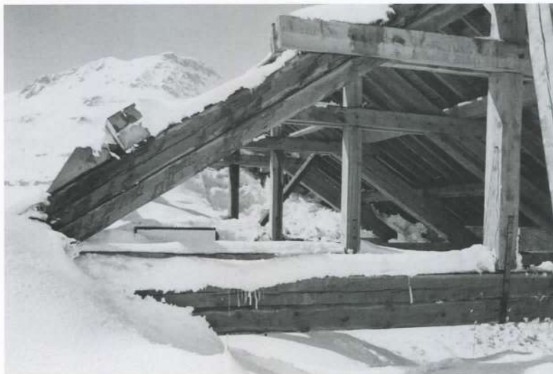
1971 hat die Lawine vom Hübschhorn das umgebaute Stallgebäude so stark beschädigt, dass es abgerissen werden musste.
