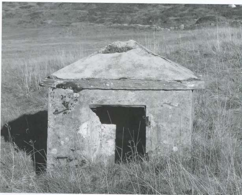
Wartungshäuschen an der alten Wasserleitung zum Hospiz
