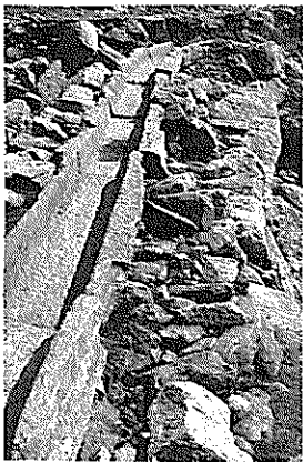
Canali in pietra dell'acquedotto dell'Alpe Canaa (Fusio).
