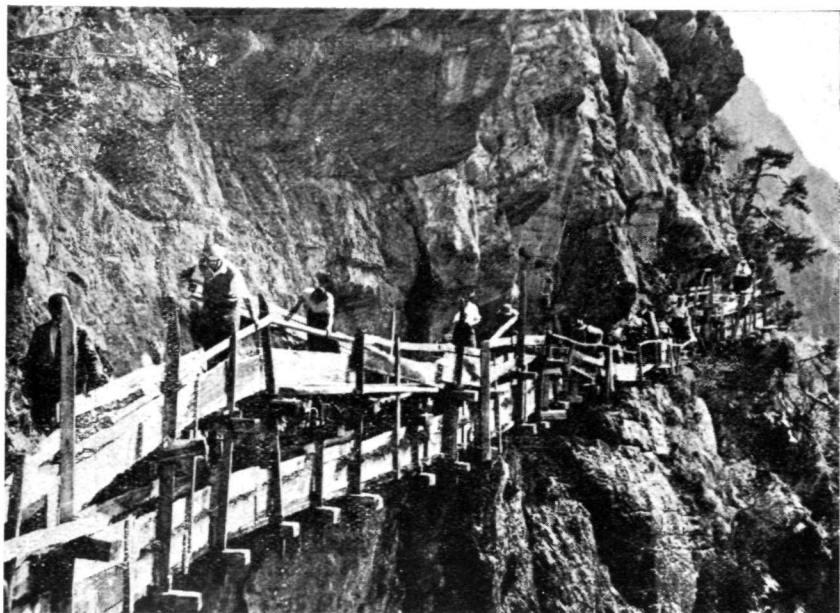
A la Grande Barne : conduite soutenue par deux rangées de consoles superposées ; passerelle aménagée au-dessus de la conduite
