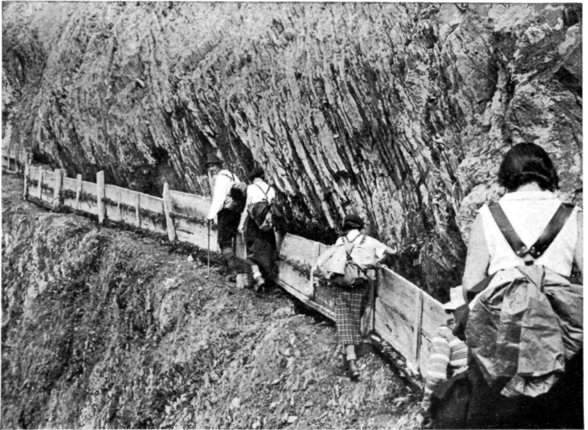
Conduite appuyée au rocher qui a été entaillé, paroi extérieure en planches
