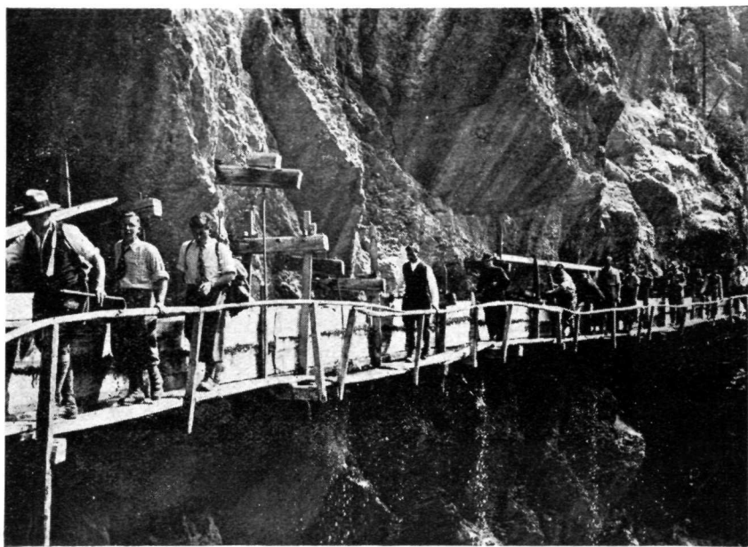
Aux Brenlires : passerelle formée par des planches posées sur les consoles inférieures. On voit quatre tiges en fer reliant les consoles
