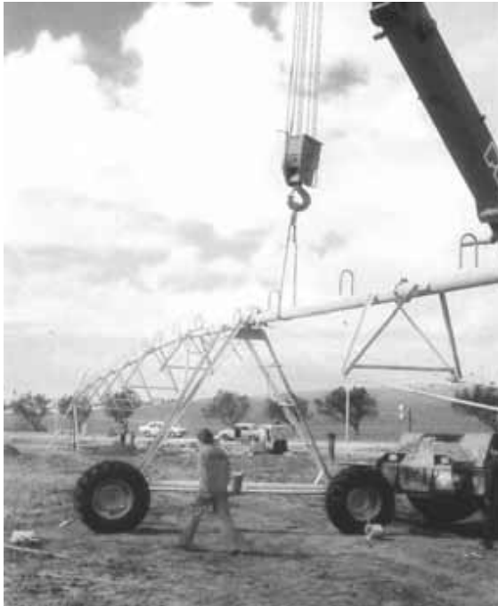
FIGURE 10.7 - Le montage du pivot central.
