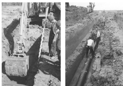
FIGURE 17.2 - Installation des conduites.
